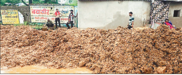
पाइप लाइन बिछने खोदा गया गड्ढा।
